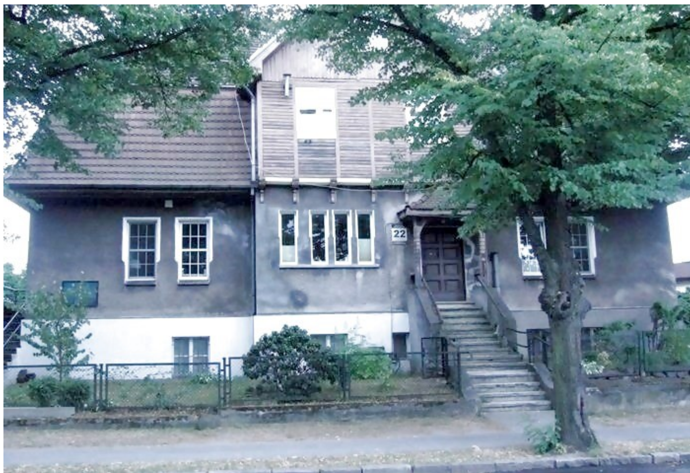
Dom przy ul. (obecnie ul. Piastowska nr.22) w Gdańsku Oliwie należący w latach 1935 - 1936 do rodziny Modrowów w którym powołano Pakt Rbbentrop - Mołotow
